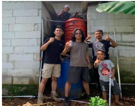
Gambar 9. Pemasangan Saluran Air ke Musholla
