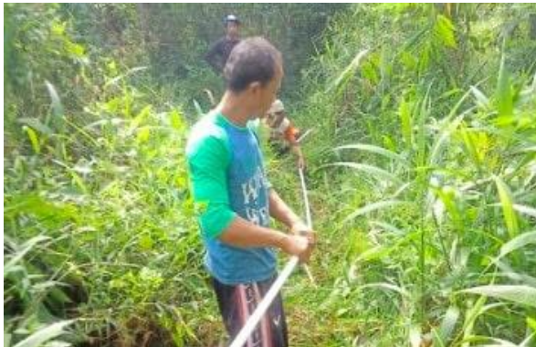
Gambar 6. Proses Pemasangan Pipa
