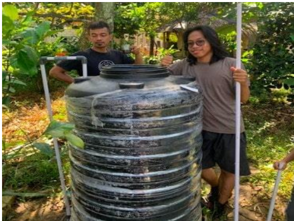
Gambar 8. Pemasangan Toren di Lokasi Akhir
