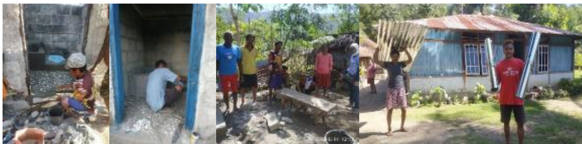
Gambar 6. Proses Renovasi Toilet Dusun Noesopu, Desa Kolbano (Sumber: Dokumentasi peneliti, 2022)
