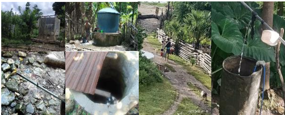
Gambar 2. Kondisi Eksisting Sistem Penyediaan Air Bersih Desa Tuafanu (Sumber: Dokumentasi peneliti, 2022)
