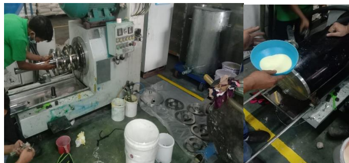
Gambar 5 & 6. Pemasangan mesin grinding pasta yang sudah dibersihkan
