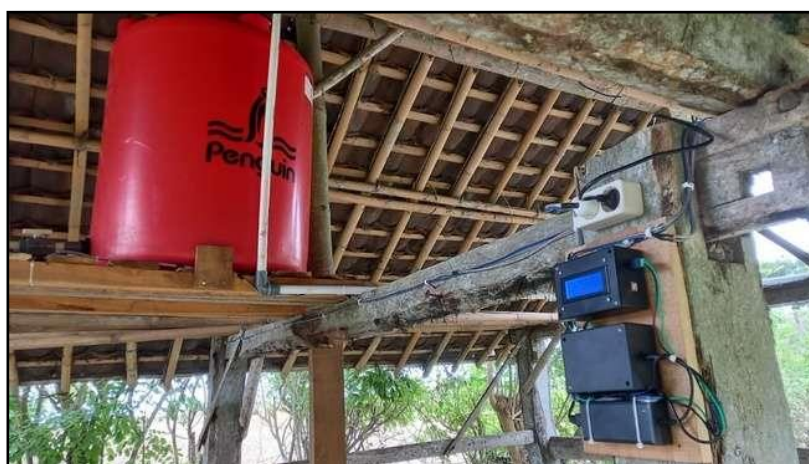
Gambar 7. Rangkaian Controller dan Tandon Air yang Akan Secara Otomatis Mengaktifkan/Membuka Keran Air pada Tandon
