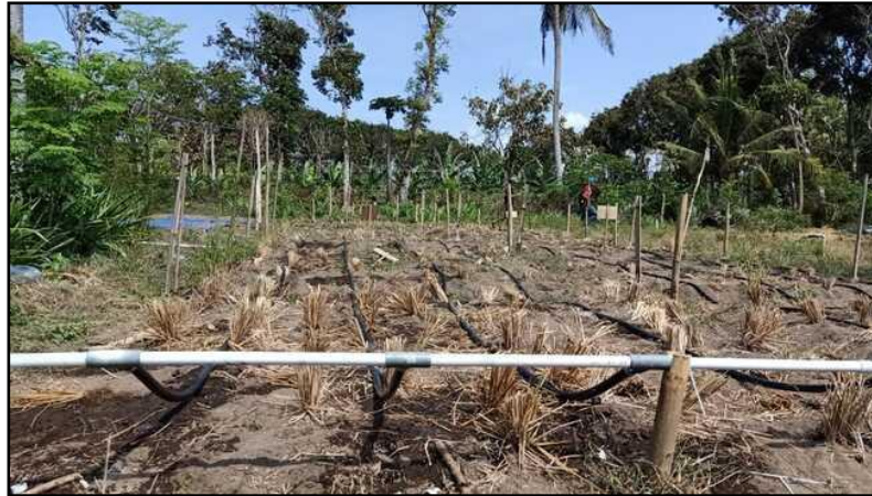
Gambar 8. Rangkaian Pipa dan Selang Automasi Irigasi Tetes pada Lahan Pasir Pantai
