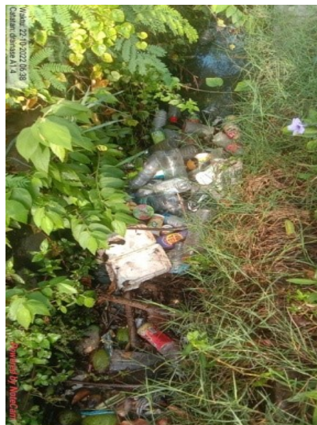
Gambar 6. Hambatan Titik Saluran Drainase A4 Berupa Rumput Liar dan Sampah
